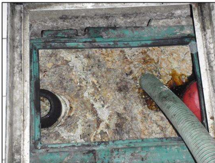
Opération de vidange d'un bac à graisses chez un restaurateur
