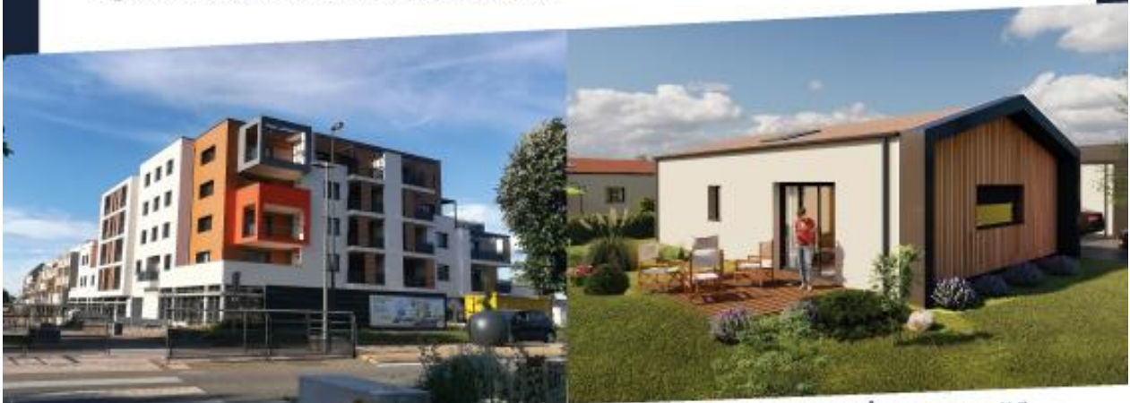
36 appartements en accession à Luc-La-Primaube (12)
